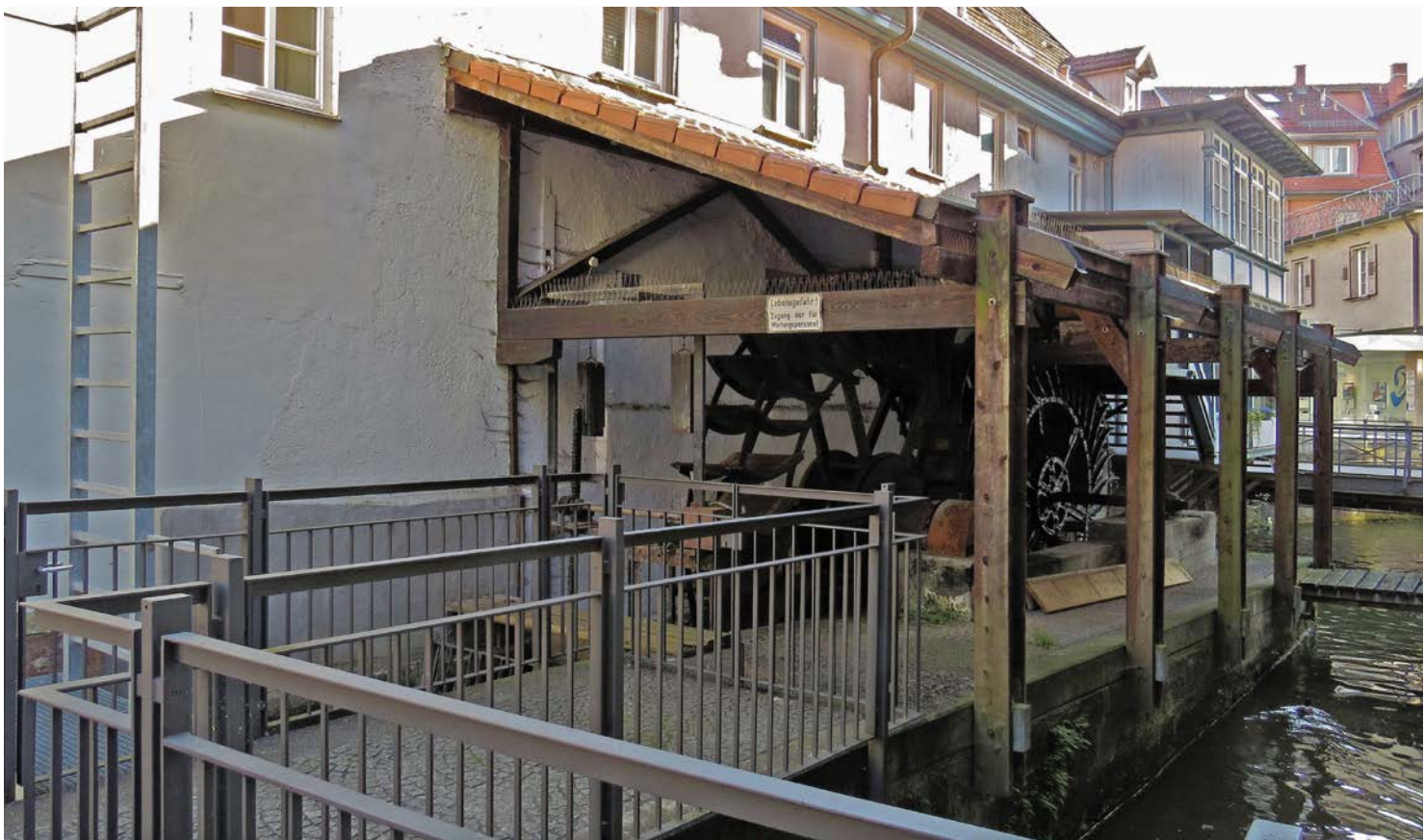
Wasserräder hinterher, einschließlich neuem Geländer
