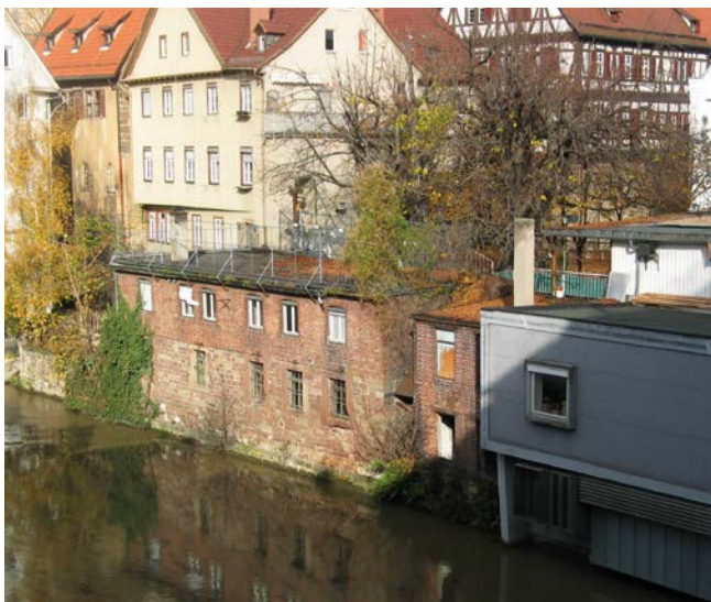
Kanzleiufer vor Abbruch Waschhäusle
