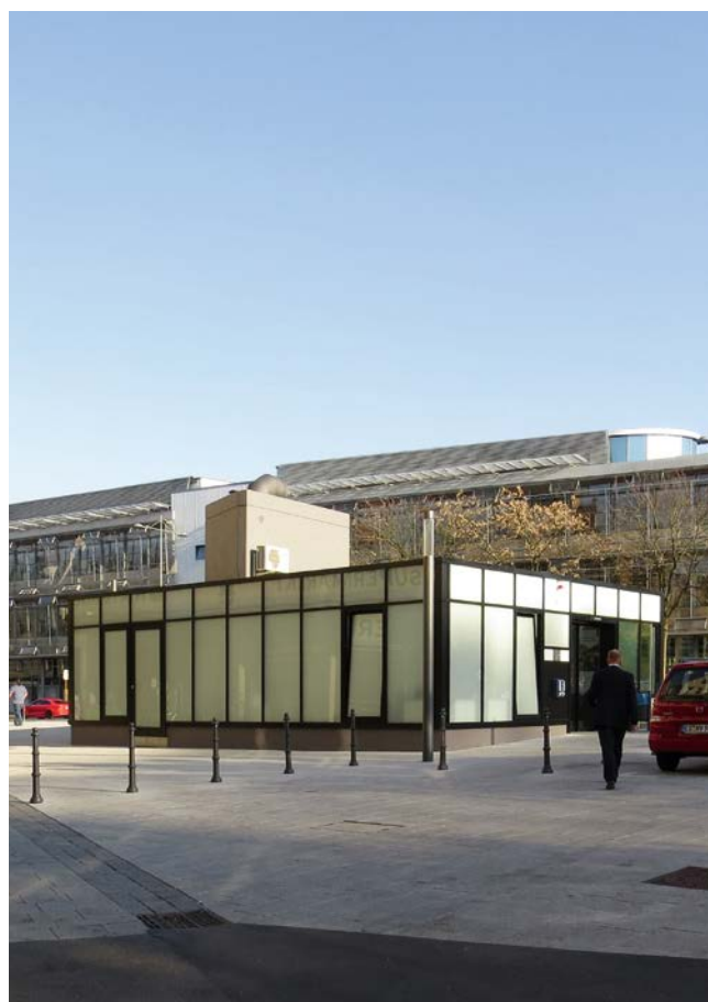
Neues Eingangsbauwerk zur Tiefgarage Kiesstraße
