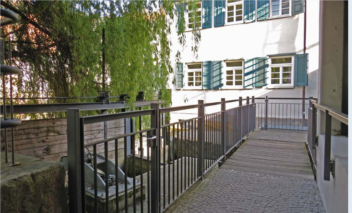
Zugang mit neuen Geländern
