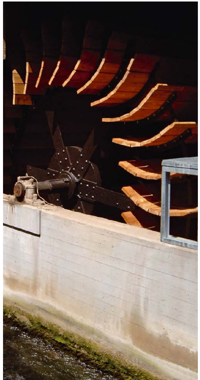
Wasserrad nach der Sanierung
