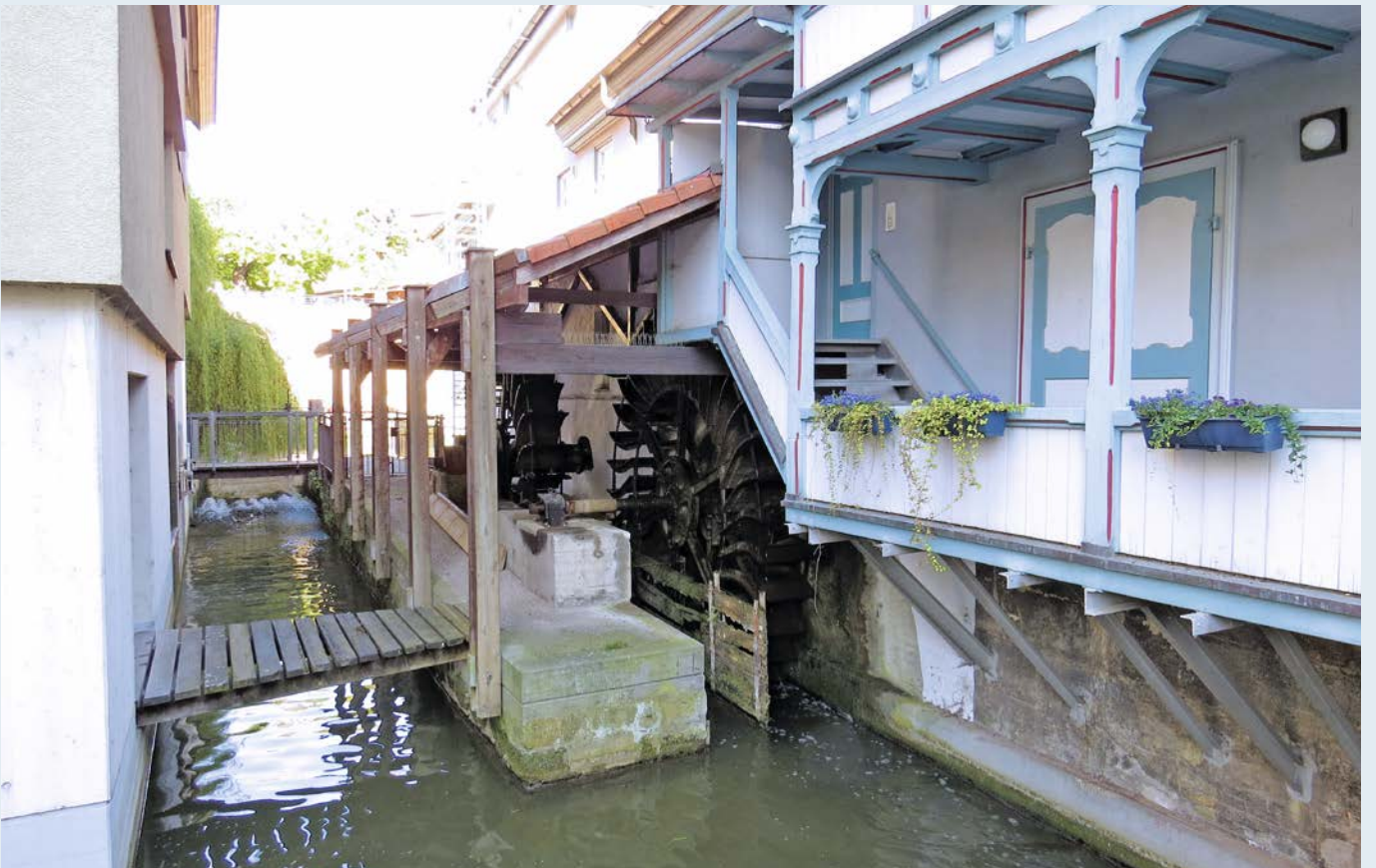
Blick von der Straßenbrücke
