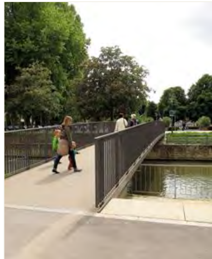
Neubau Fußgängerbrücke über den Roßneckar mit Sitzstufen
