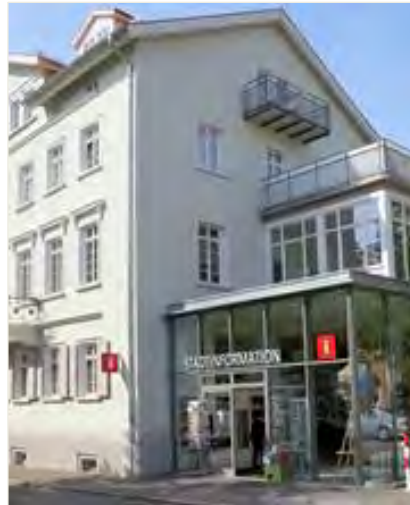
Sanierung „Späthsches Haus“ Marktplatz 16
