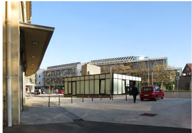
hinterher, mit neuem Eingangsbauwerk zur Tiefgarage
