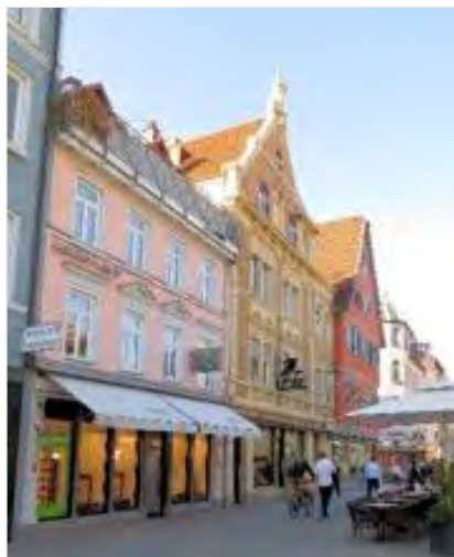
Sanierung Innere Brücke 18
