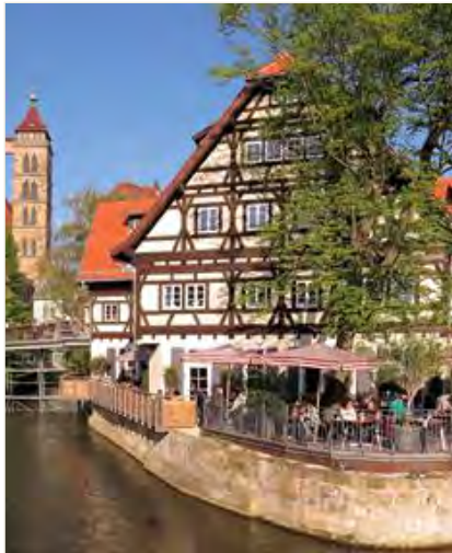
Sanierung ehemaliges Weissinger-Areal
