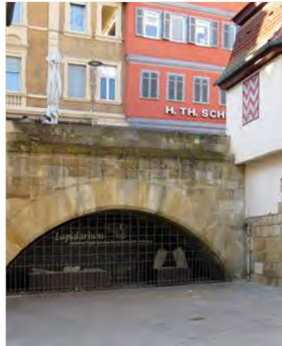
Öffnung der Brückenbögen Innere Brücke mit Lapidarium
