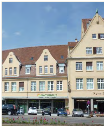
Sanierung der „Alten Feuerwache“
