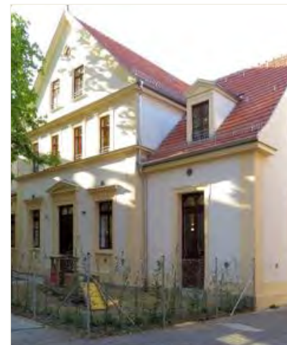
Sanierung ehemaliges Bethaus Adlerstraße 4
