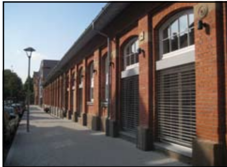
Das historische Sichtmauerwerk an der Weilstraße
