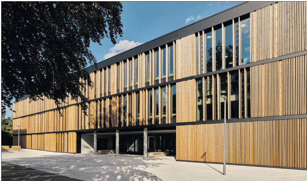
Von den Treppenhäusern abgesehen, wurde die Schule komplett in Holzbauweise errichtet. Auch innen ist die Realschule ein Hingucker und verfügt nicht nur über 20 moderne Klassenzimmer, sondern auch tolle Lernbereiche. Fotos: Gunnar Menzel / fritzen28
