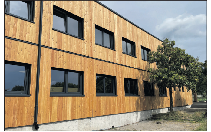
Die Stahlkonstruktion mit Holzfassade ist eine ansprechende und kostengünstige Lösung.
