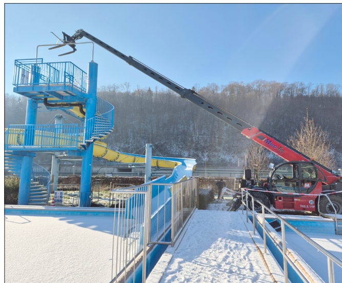
Im Neckarfreibad wird die Rutsche ausgetauscht.
