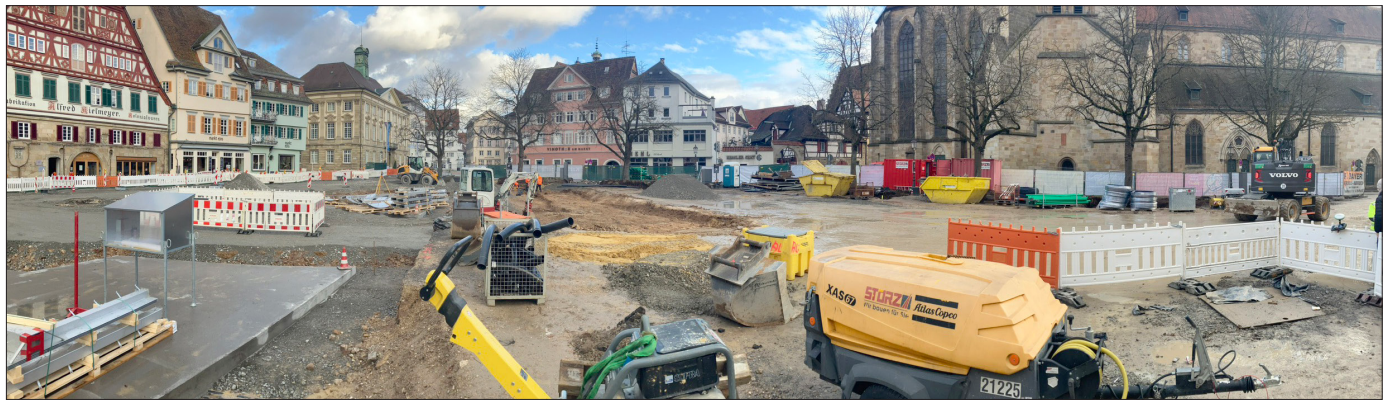
Links im Bild ist bereits das Fundament für das zukünftige Fontänenfeld zu sehen, in Kürze werden die Düsen installiert.
