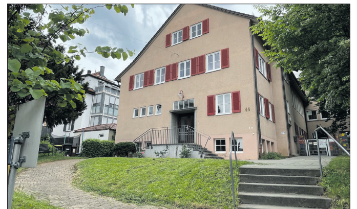
In die Rosenstraße 44 ist bereits neues Leben eingezogen.
