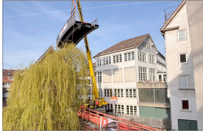
Millimeterarbeit: Die neue Brücke wurde per Lastwagen angeliefert, mit einem Kran über das (unbewohnte) Haus am Kesselwasen 12 manövriert und in vier Betonverankerungen installiert.
