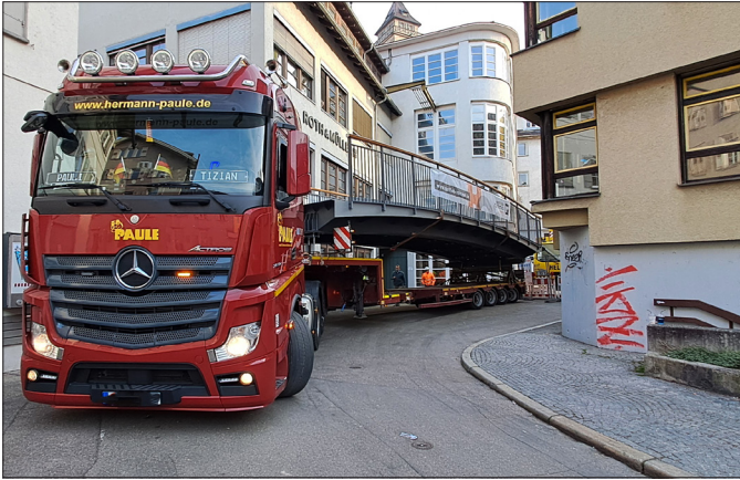
Millimeterarbeit: Die neue Brücke wurde per Lastwagen angeliefert, mit einem Kran über das (unbewohnte) Haus am Kesselwasen 12 manövriert und in vier Betonverankerungen installiert.
