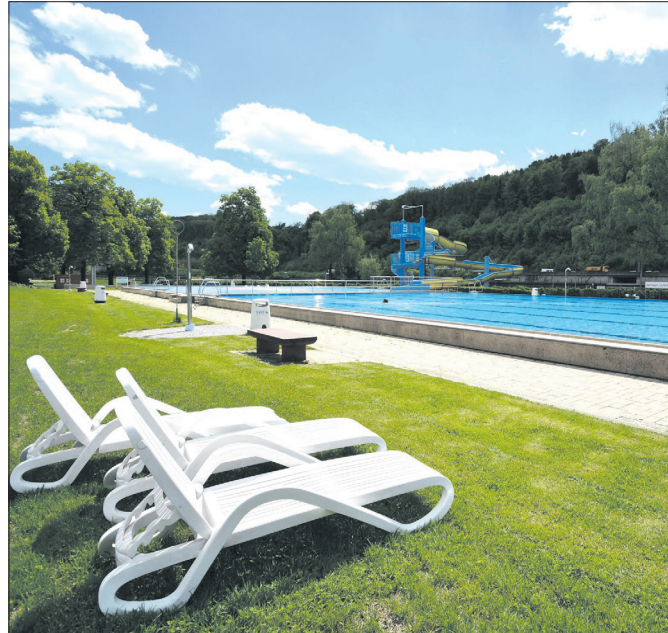
Im Neckarfreibad wurden die Filteranlagen für die Wasserreinigung saniert. In beiden Freibädern wird das Grün für den Saisonstart vorbereitet. Foto: Stadtwerke Esslingen
