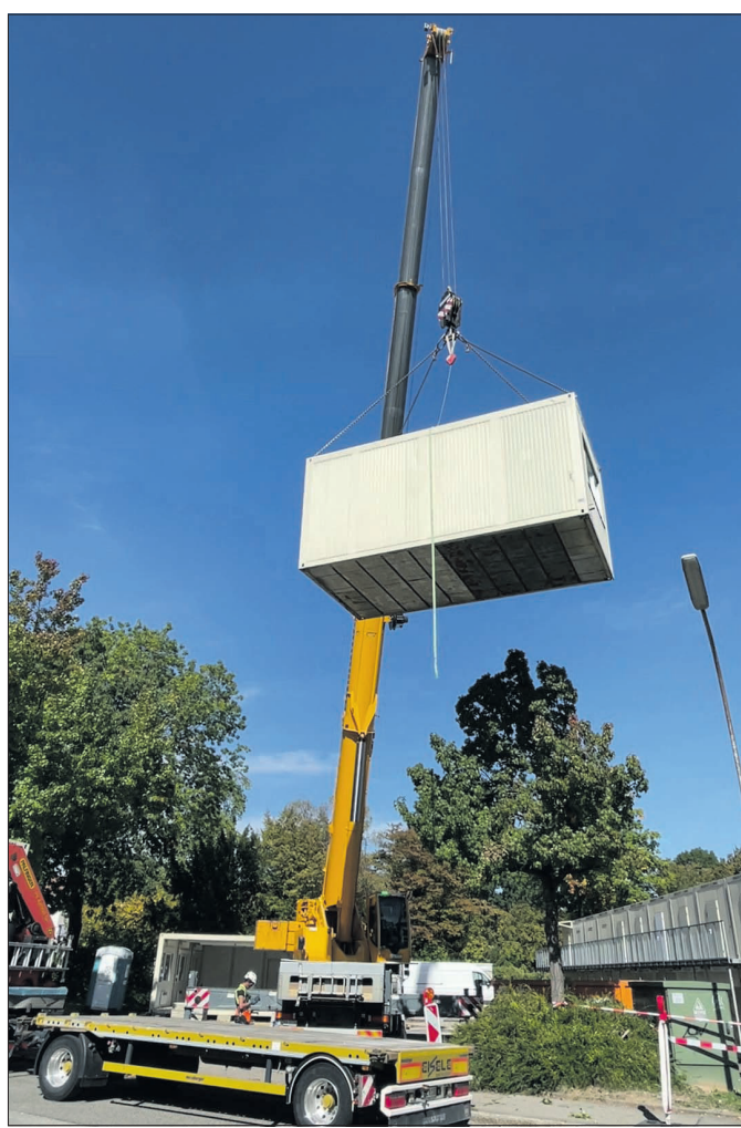
Die insgesamt 70 Container wurden im Jahr 2019 aufgestellt.
