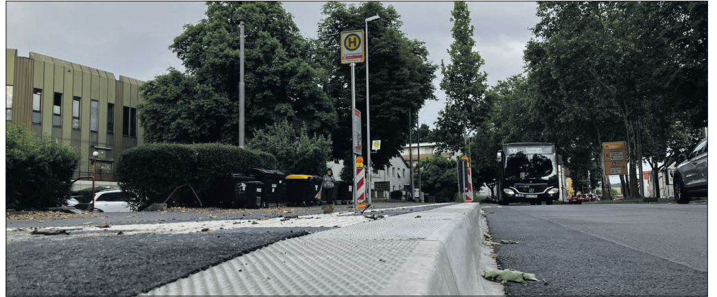
Die Bushaltestelle Lammgarten wurde bereits vor kurzem barrierefrei umgestaltet, weitere Haltestellen folgen.
