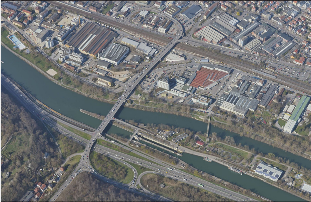
Aktuell ist die Adenauerbrücke verkehrssicher und wird engmaschig überwacht – im Sommer steht die routinemäßige Hauptprüfung an.
