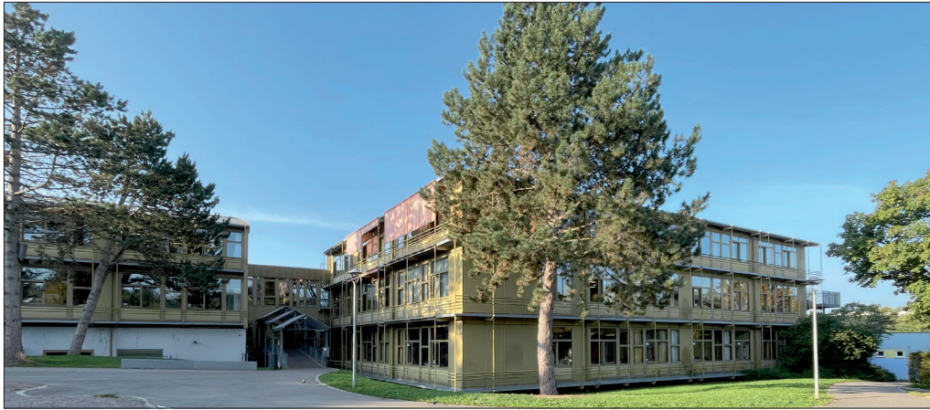
Frühmorgendliches Lüften und das Schließen der Fenster bei Hitze sind erste, einfache Maßnahmen. Foto: Schelztor-Gymnasium
