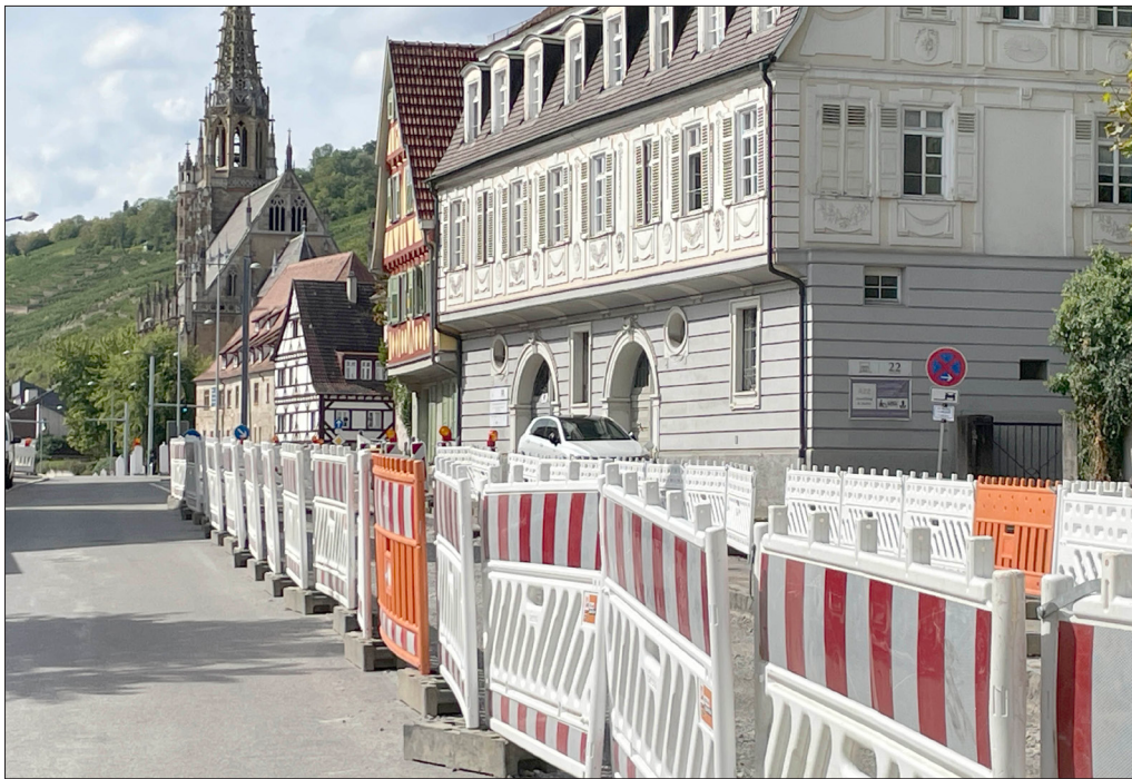
Altstadttring: Die Arbeiten an der Augustiner Straße dauern aufgrund von Lieferschwierigkeiten bis Ende Oktober.
