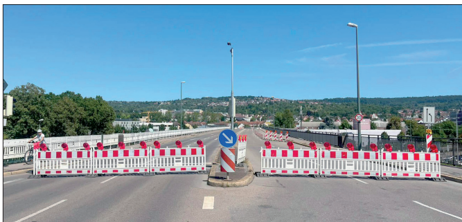
Seit einer Woche ist der nördliche Teil der Adenauerbrücke für den motorisierten Verkehr gesperrt – nur Radfahrende sowie Fußgängerinnen und Fußgänger dürfen durch. Foto: nia
