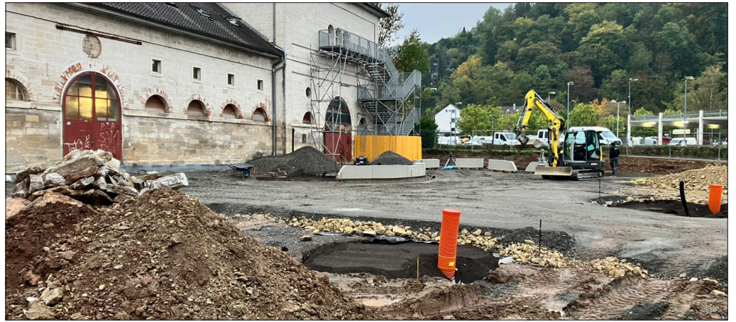
Bis zum Frühjahr soll der neue Stadtteilplatz vor dem Marstallgebäude fertiggestellt sein.
