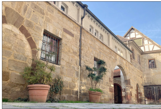
Die Stadtbibliothek wird im Pflegehof saniert.
