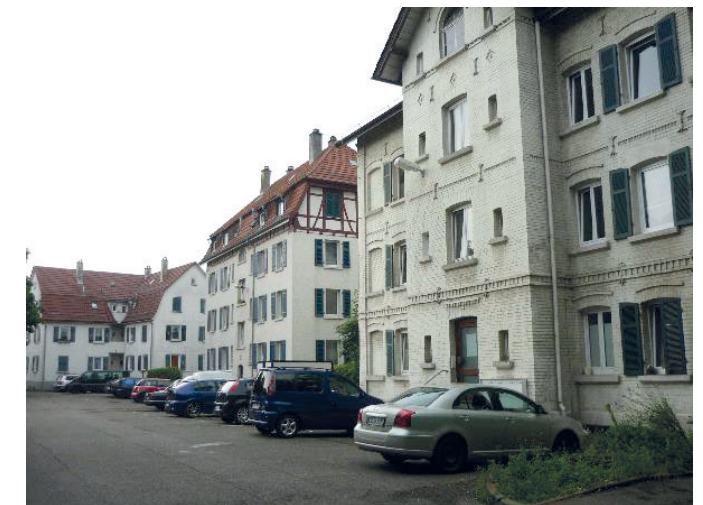
Abbildung 40: Arbeiterhäuser Heinrich-Gyr-Straße | Quelle: C.Paulitschek
