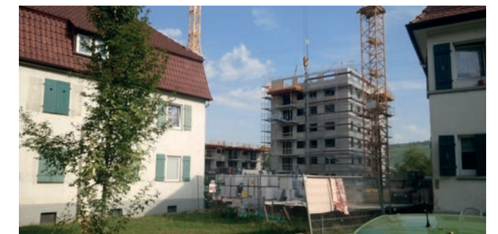
Abbildung 38: Bestandsgebäude - zukünftiges Quartierszentrum mit Baustelle „Wohnen am Wasser“ | Quelle: Stadtberatung Dr. Sven Fries
