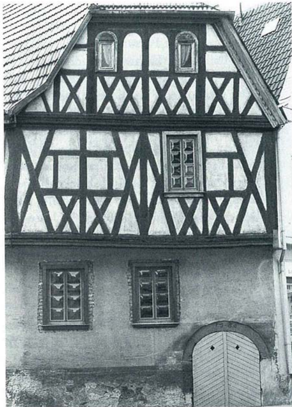
14. Dieburg, Rheingastr. 5, Fachwerkbau von 1566 vor Instandsetzung der Fassade
