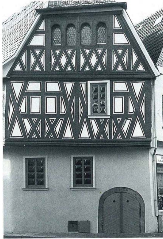
15. Dieburg, Rheingastr. 5, nach Fassadeninstandsetzung in Anlehnung an historische Farbigeit. Durch die Verbreiterung der Balken und die befundorientierte Gefachgestaltung verändert sich das Gesamtbild der Fassade grundlegend
