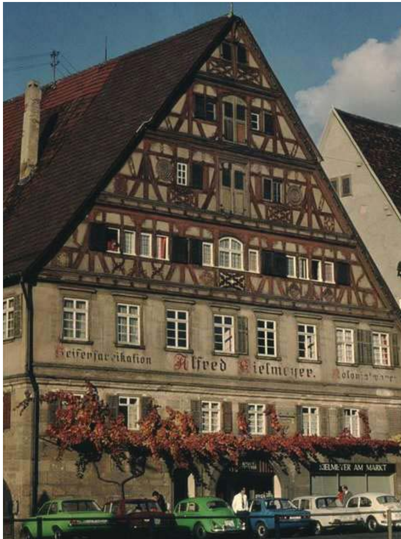
Ansicht Kilmeyerhaus, 1978, Landesdenkmalamt Esslingen.
