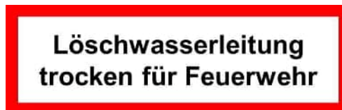
Abbildung 10 Kennzeichnung der Löschwasserentnahme ("trocken") © Feuerwehr Esslingen a. N.
