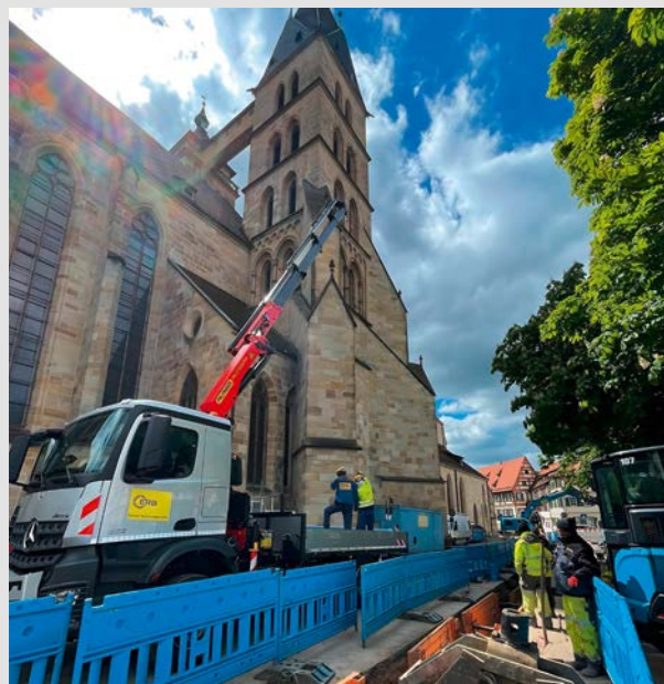
Marktplatz Esslingen: Auswechslung einer Wasserleitung am Esslinger Marktplatz
