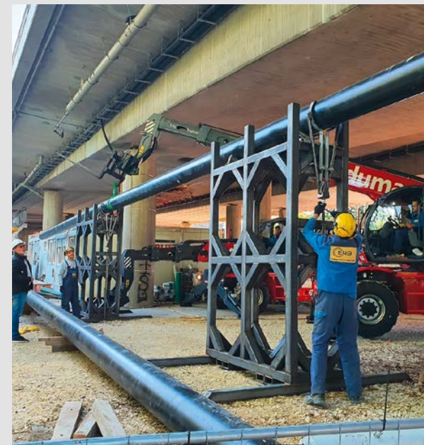
Vogelsangbrücke Esslingen: Gasleitung unter der Vogelssangbrücke über dem Neckar – präzise hängend verlegt mit einer innovativen, patentierten Montagehilfe aus eigener Entwicklung durch H. Erb
