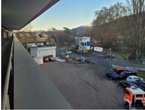
Erstellung der Behelfsausfahrt
