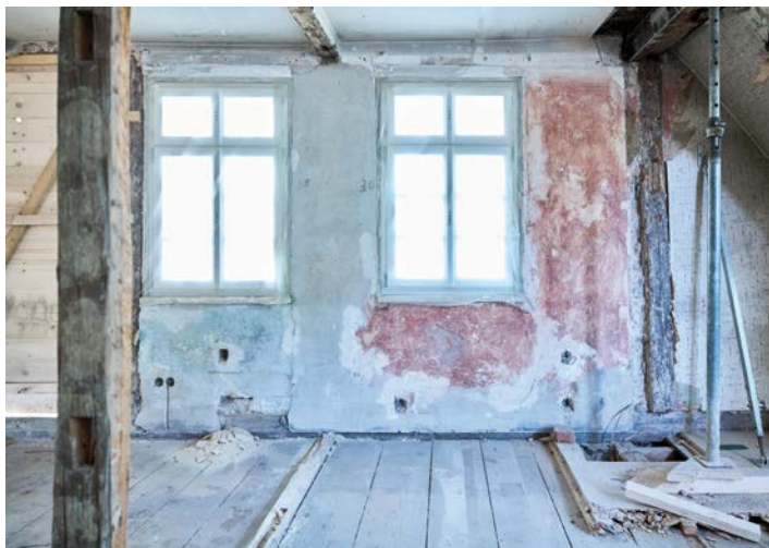
Renovierung Apothekergasse 2 | © Sommerfeld Energieberatung
