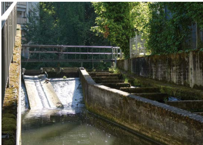
Wehr am Rossneckarkanal beim Lohwasen
