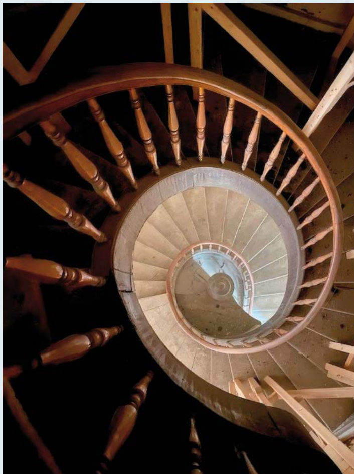
Treppenhaus des herrschaftlichen Mietwohnhauses Vogelsangstraße 12 | © Springmann Architektur GmbH
