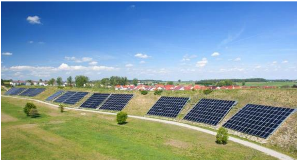
Abbildung 3-3 Freiflächen-Solarthermieranlage in Crailsheim [ www.sonnewindwaerme.de/solarthermie/solare-waermenetze-baden-wuerttemberg ]
