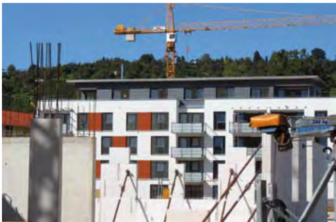
Baustelle Grüne Höfe
