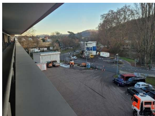
Erstellung der Behelfsausfahrt
